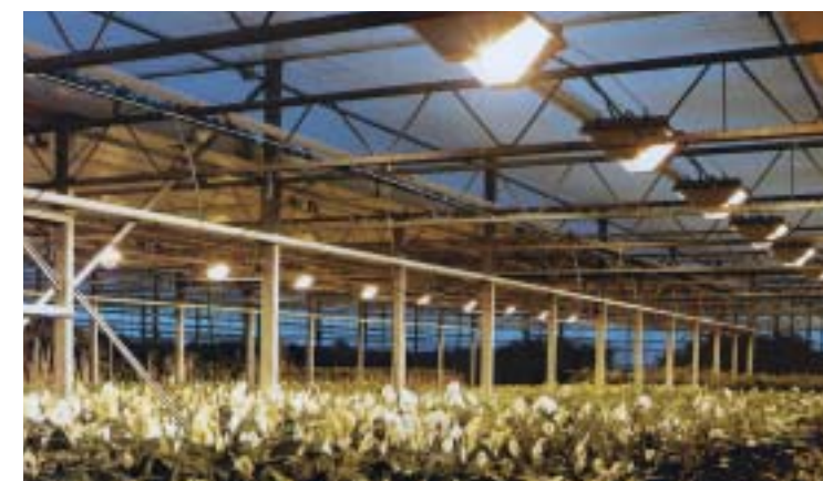
SISTEMA DI ILLUMINAZIONE SUPPLEMENTARE
