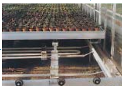
RISCALDAMENTO SOTTO BANCALE
