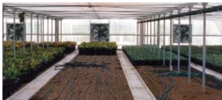
RISCALDAMENTO BASALE
