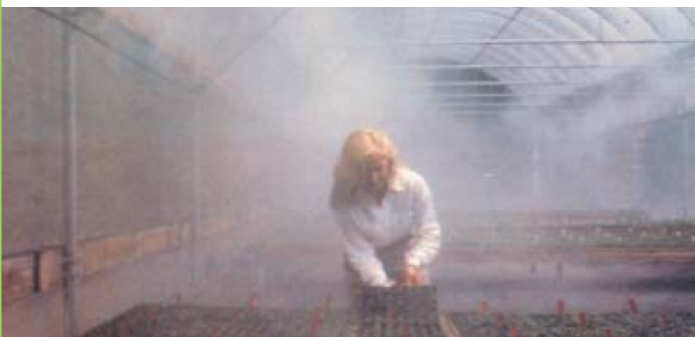
Ventilatori di ricircolo - Umidificazione a nebbia (sistema fog)
