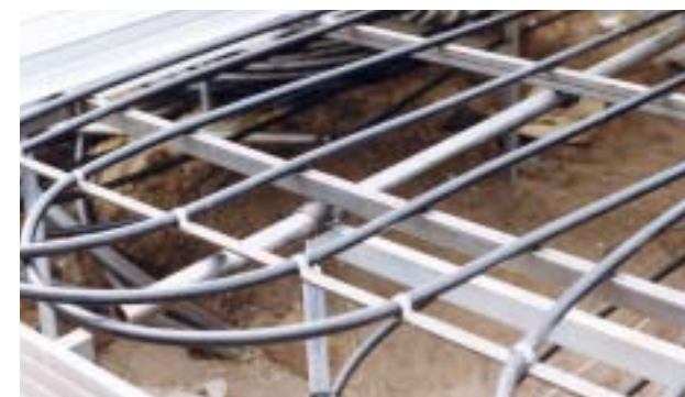
PARTICOLARE RISCALDAMENTO BANCALI MOBILI
